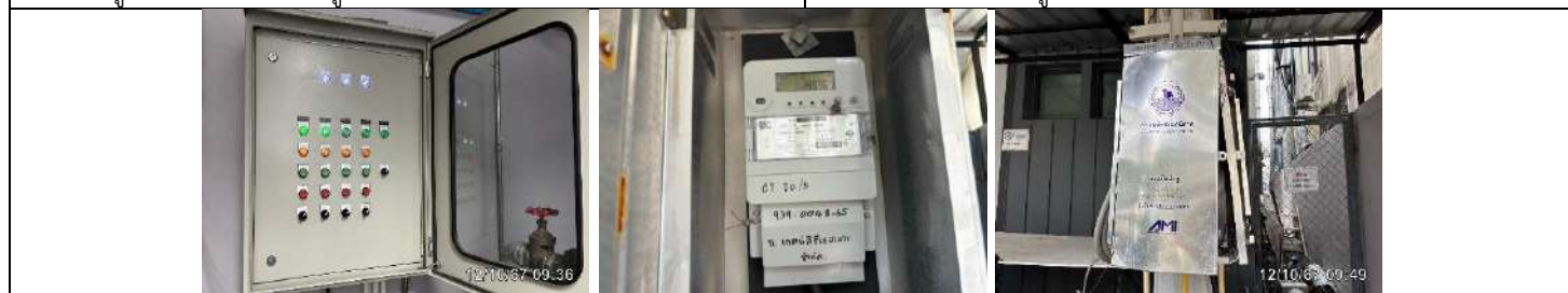
รูปที่ ผ7.9 ตู้ควบคุมระบบบำบัดน้ำเสีย
