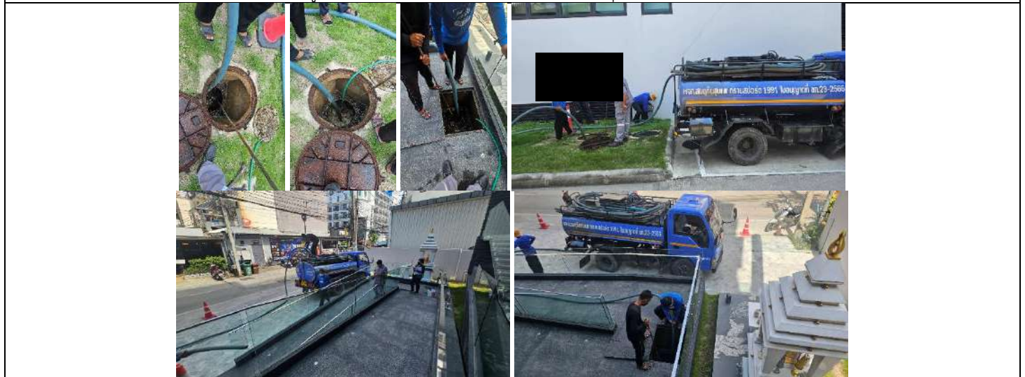
รูปที่ ผ7.57 การสุบตะกอนส่วนเกินออกจากถังบำบัดน้ำเสีย
